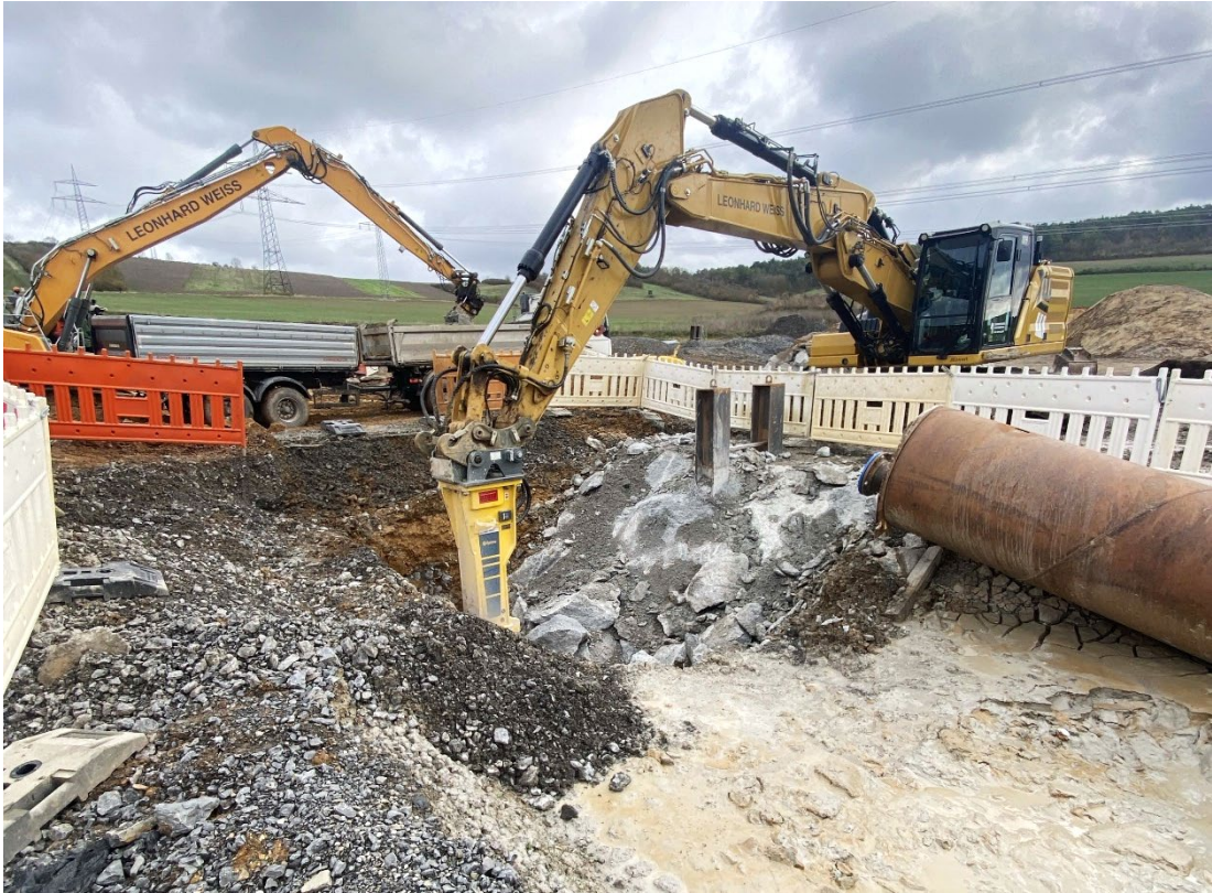
Rückbau eines Widerlagers im Baulos 9 neben der B290 Lauda-Königshofen / Tauberbischofsheim
