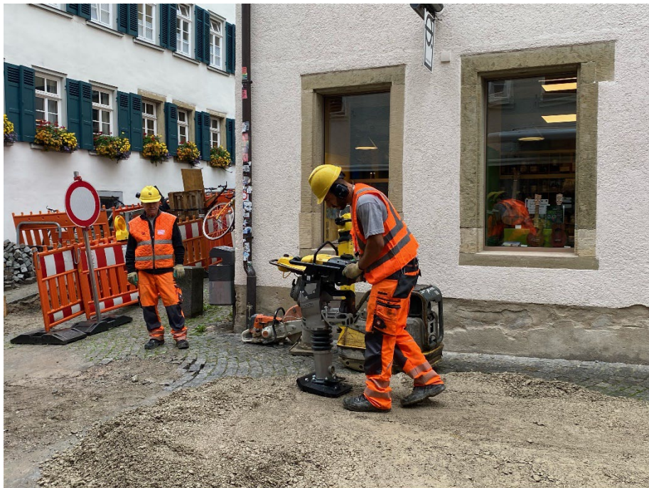
Der elektrisch betriebene Stampfer wurde am 2. August im Vergleich zum konventionellen Gerät gezeigt. Auffällig beim E-Stampfer: keine Gerüche.
