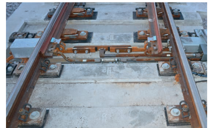
Weichenverschluss- und Antriebstechnik nachher ▲
